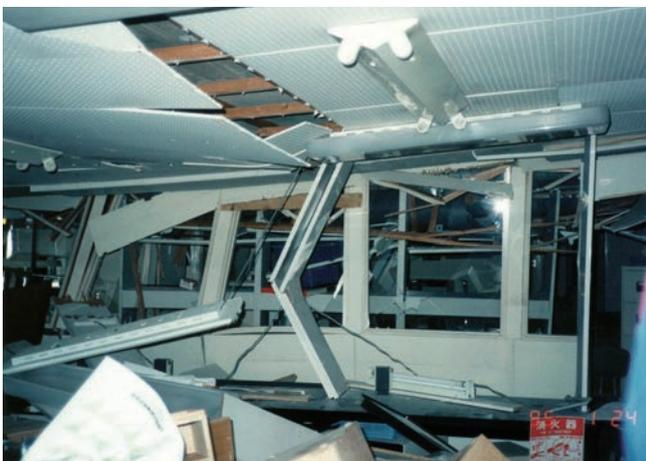
全壊の保健環境検査センターの内部 天井が剥がれ柱が曲がっている。
