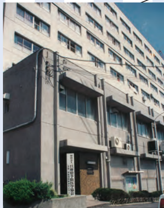
▲1987年～ 旧神戸市土木局東部事務所東灘分室庁舎。震災で全壊となった。(神戸市東灘区)
