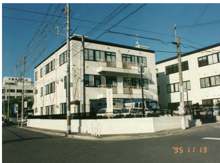
新たに建設した保健環境検査センター 右が事務所棟、左奥に集団健診センターが見える。
