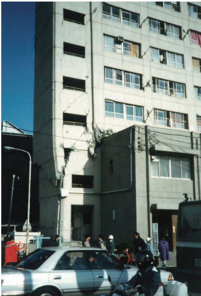
全壊した保健環境検査センター
