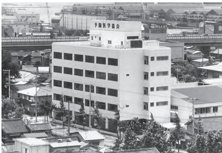
御影町役場跡地に建設した本館
