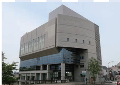
▲2006年～ 住民健診の業務量増大に対応するため、灘区民ホール3階に灘分室を開設。(神戸市灘区)
