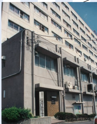
▲1987年～ 旧神戸市土木局東部事務所東灘分室庁舎。震災で全壊となった。(神戸市東灘区)
