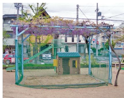
周囲をネットで覆った公園内の砂場 出入り口の開閉をきちんと行えば、この方法で猫の便の混入を確実に防げる。安全性や効果の持続期間も満足のいくものである。
