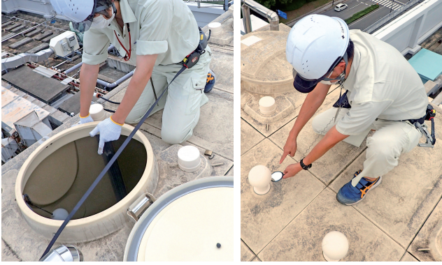
簡易専用水道検査の様子
