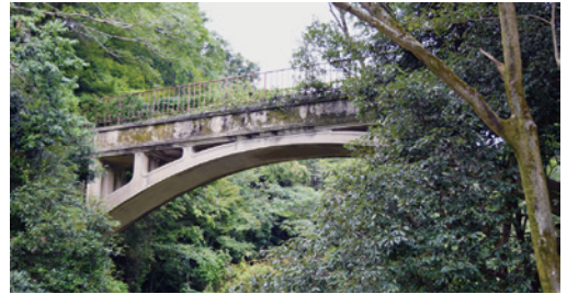
コンクリ橋 どこにも通じない不思議な橋と言われていた。
